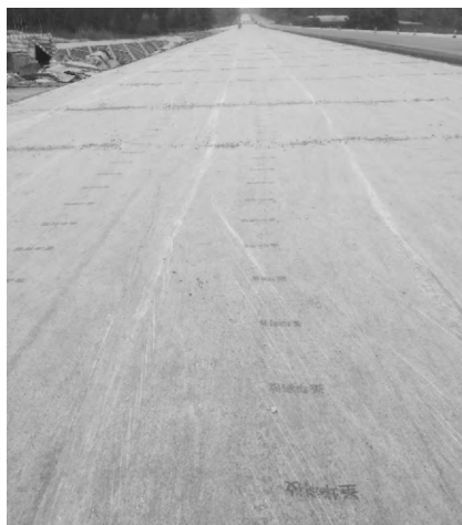
图 3 水稳底基层薄膜养生
