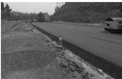
图 1 水稳底基层初压施工
