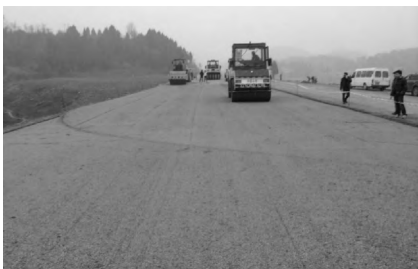
图 2 水稳底基层碾压成型
